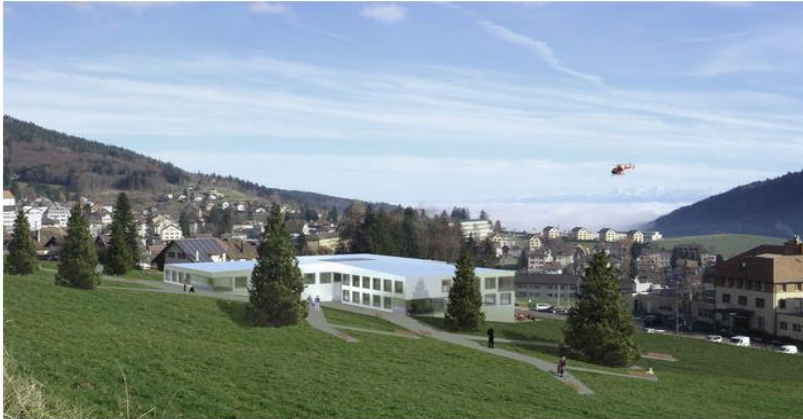
Le bâtiment de Patrick Minder joue avec la déclivité du terrain: à chaque étage, il existe une sortie de plein pied
